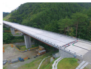
供用後の名称：田野畑普代大橋 写真提供：西武建設
